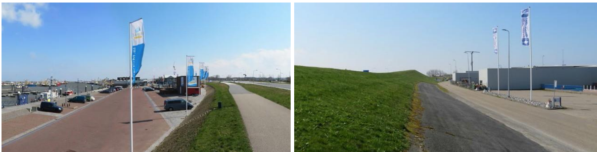
Figuur 3: Links zeezijde (Waddenzeehaven), en rechts binnentalud (Lauwersmeer) van het haven tracé Lauwersmeerdijk
