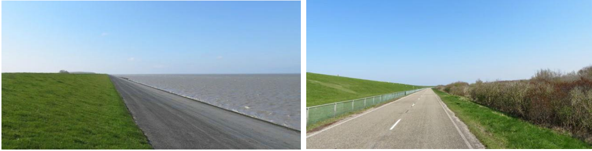
Figuur 2: De linker afbeelding is de zeezijde (Waddenzee), en de rechter afbeelding het binnentalud (Marnewaard) van het landelijk tracé Lauwersmeerdijk
