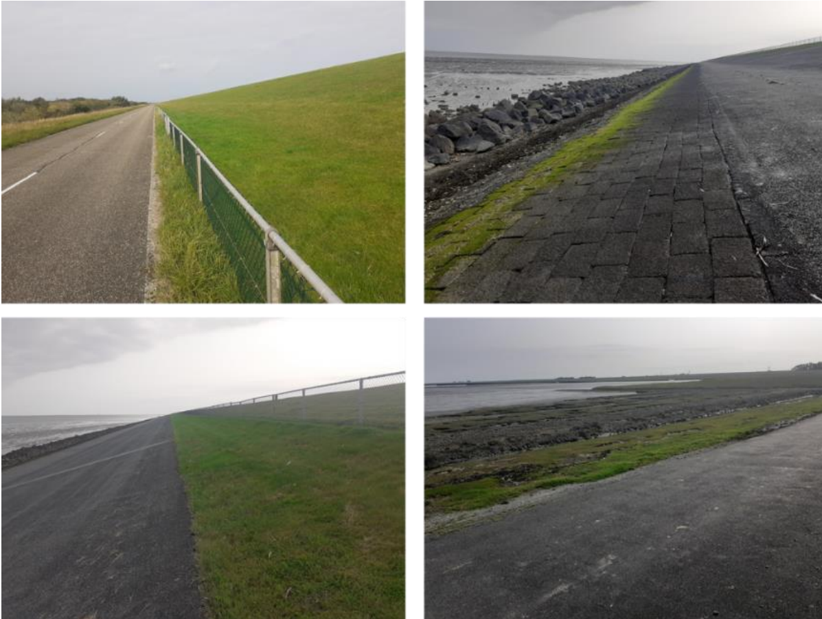
Foto 2-2 Impressie van de Landelijke dijk (binnendijks met onderhoudsweg defensie (Kustweg) en buitendijks met teenbestorting-asfaltbekleding (tevens onderhoudsweg/fiets-voetpad) en grasbekleding
