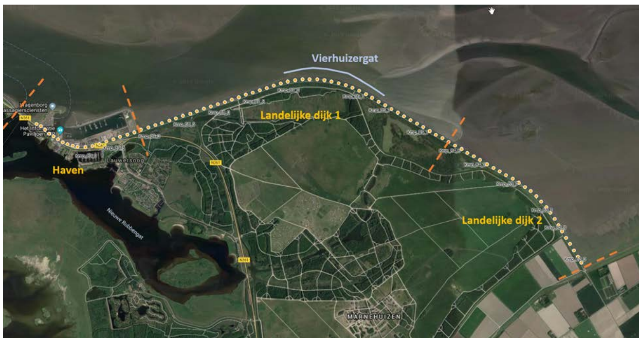
Figuur 10: de verschillende dijktrajecten vanuit de lucht gezien
